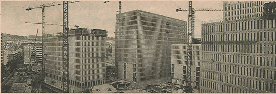
La ciudad de la Justicia en Barcelona es un ejemplo de este sistema de edificación
