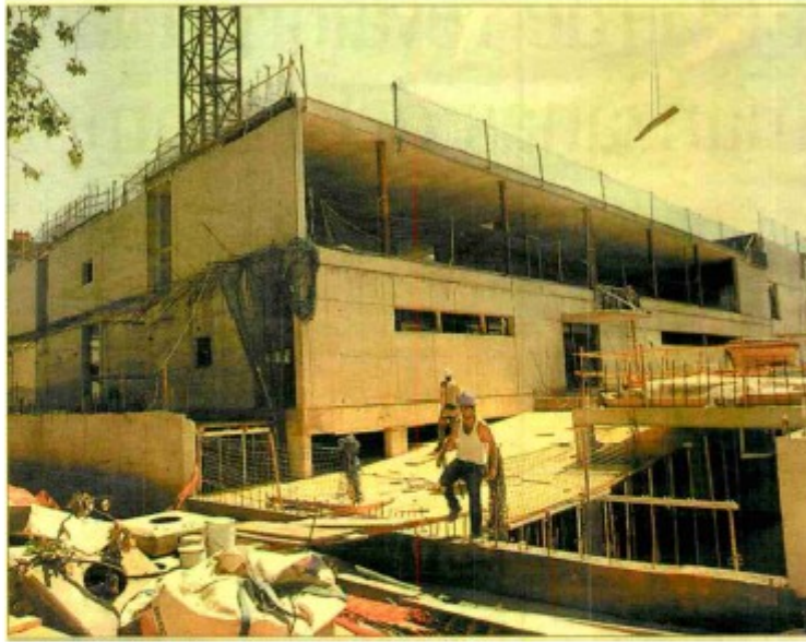
Comisaría de los Mossos d'Esquadra que se construye en la Zona Franca.
