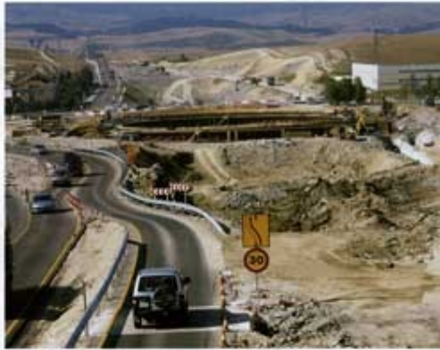
Obra en la carretera de Zor (Náser).
