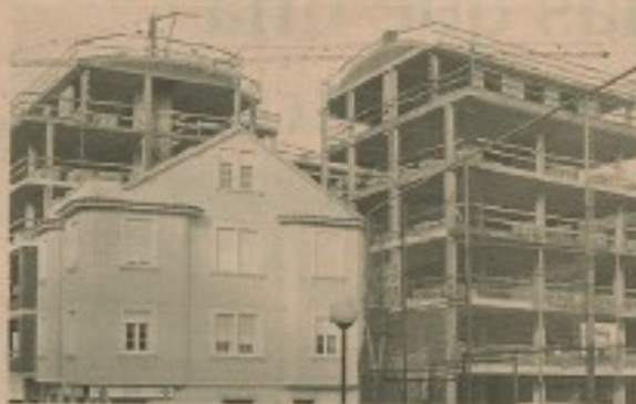
La etapa constructiva es fundamental para garantizar calidad
